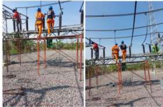
Gambar 9: Proses Perbaikan Anomali Hotspot
